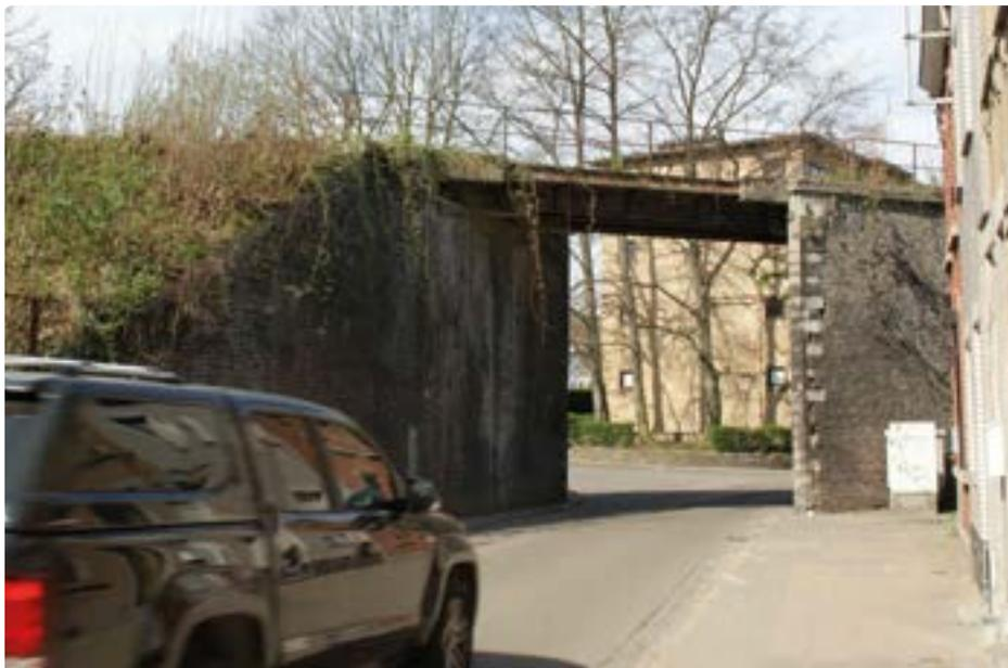
Dans les prochains jours, Infrabel va entamer la démolition de l'ancien viaduc qui passe au-dessus de la rue Faurieux, et du pilier gauche (en montant) du viaduc. Ces travaux vont nécessiter la fermeture complète de la rue à hauteur du viaduc pendant environ une dizaine de jours. La rue étant un important
